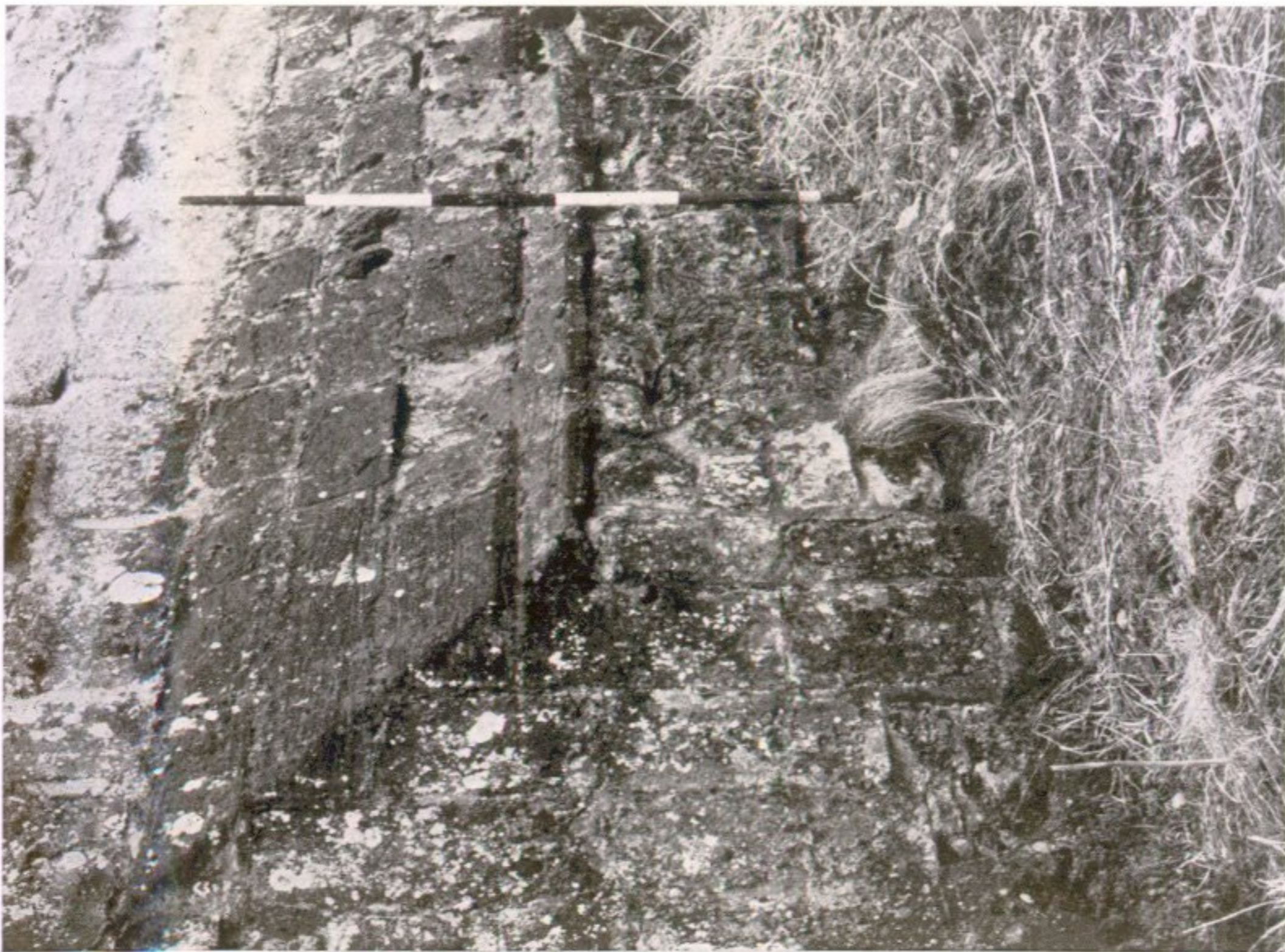
1. Base of N. Curtain
